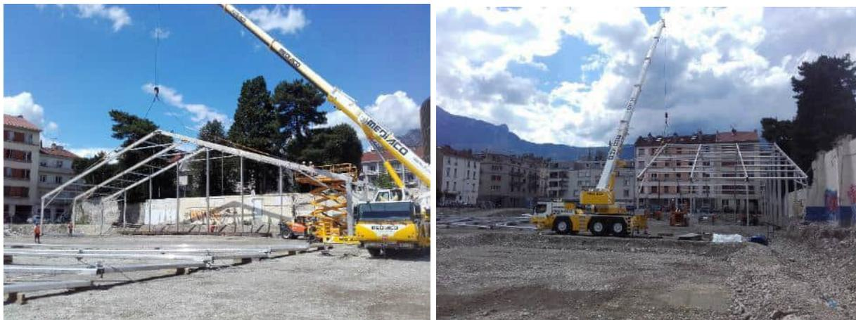
Figure 6 : Exemple de montage d'une tente de confinement (Chantier ORTEC SOLEO)
