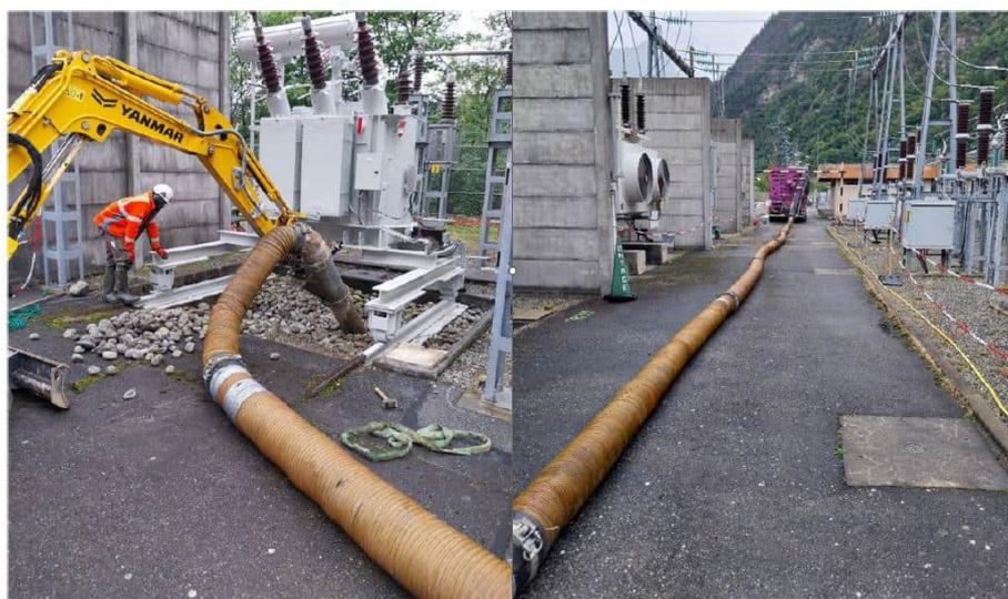
Figure 11 : Aspiratrice mise à disposition du chantier – Tuyaux d'aspiration
